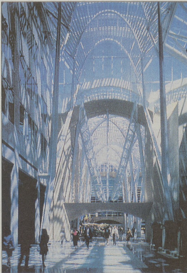
Łukowate żebrowanie galerii w Toronto
