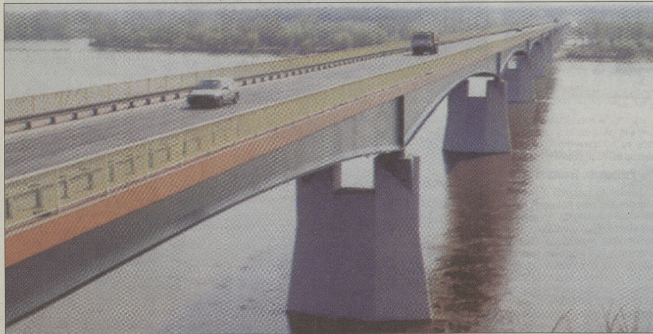
17 - przęsłowy most w Wyszogrodzie o długości 1200 metrów
