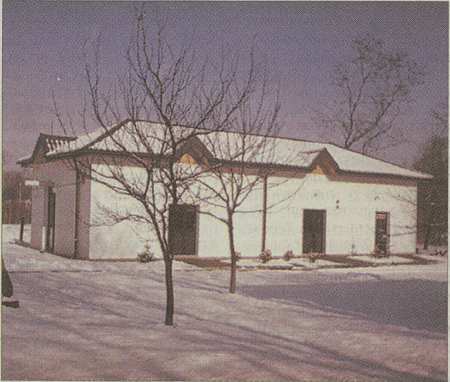
Nowoczesna stacja uzdatniania wody Fot. archiwum Miejskiego Zakładu Wodociągów i Kanalizacji
