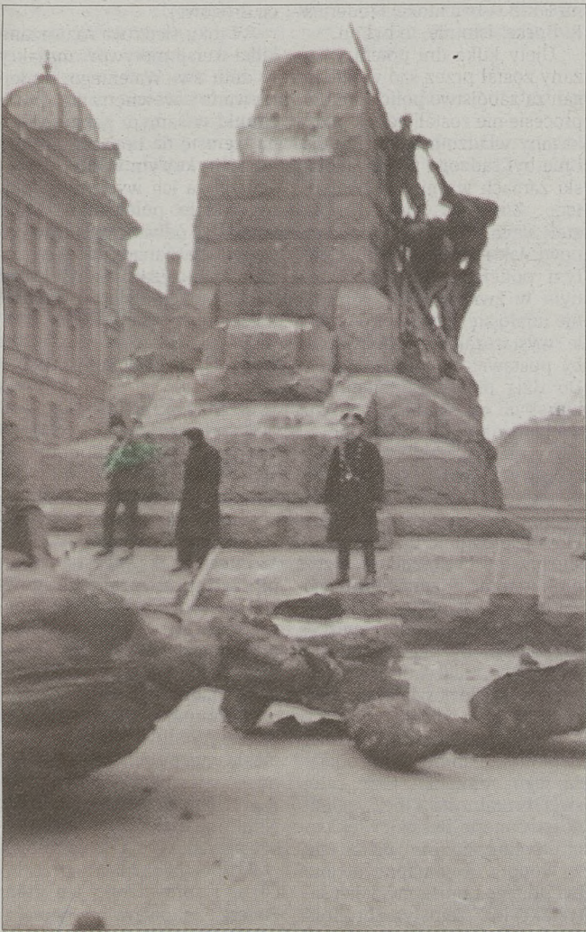
Pomnik Grunwaldzki podczas rozbiórki...
