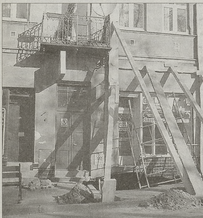
Ściany podparto drewnianymi stemplami
