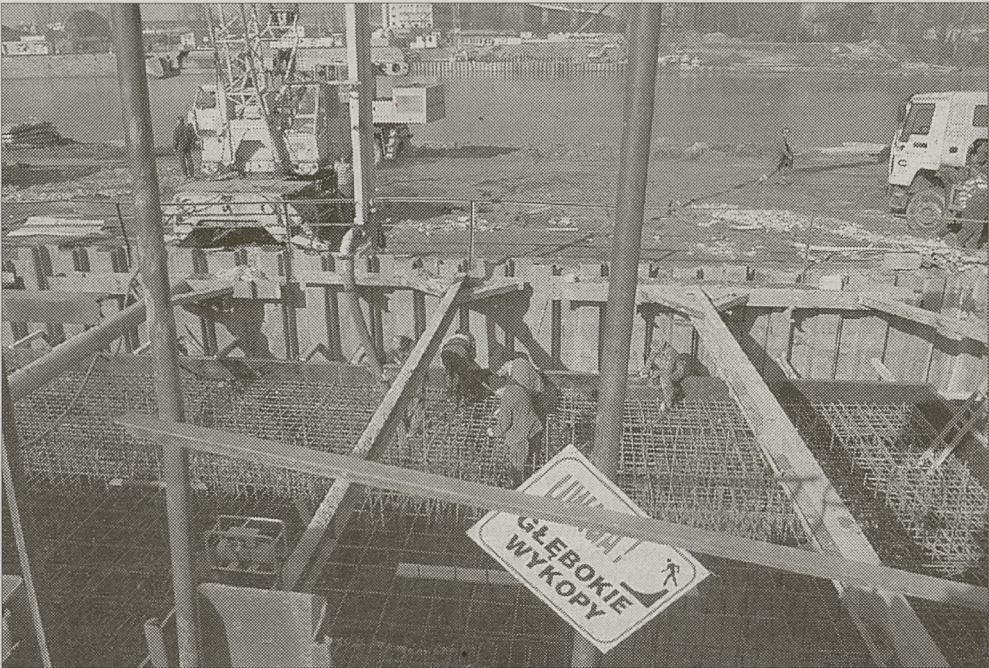
Tysiąc kubików betonu wylano pod fundament filaru mostu Kotlarskiego
