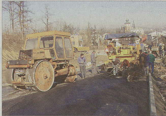
Końcowe równanie warstwy wiążącej
