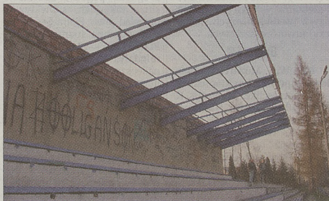
Na razie przez stalową konstrukcję widać błękit nieba
