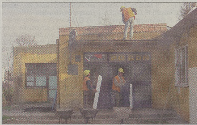
Trwa lepikowanie i ocieplanie dachu na obiekcie MKS Pogoń
