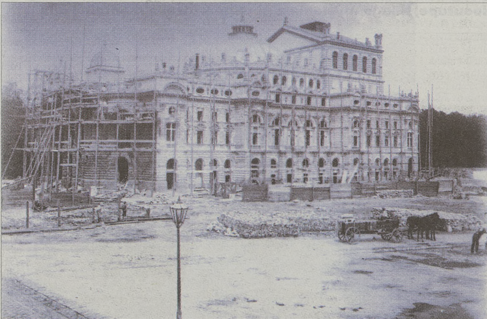
Budowa przy pl. św. Ducha
