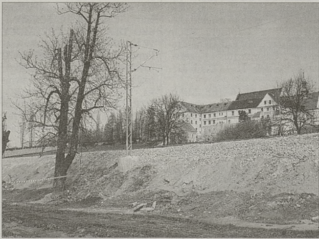
Wyrównano już zapadlisko, jakie powstało pod torem kolejowym dokładnie nad poprzeczną Mina w wyniku wycieku przed 7 laty. Wkrótce pociągi pasażerskie będą znów przejeżdżać obok widocznego w głębi klasztoru Franciszkanów-Reformatów. Fot. Agnieszka Porąbka
