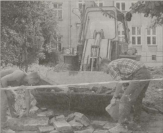
Żeby ułożyć kostkę brukową, trzeba uprzątnąć stare betonowe płyty
