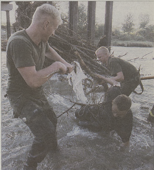
W Małopolsce trwa usuwanie szkód po powodzi. Do prac włączyli się żołnierze 5. Pułku Dowodzenia z Krakowa. W Zborowicach koło Ciężkowic likwidują zatory na rzece Białej (dopływ Dunajca).
