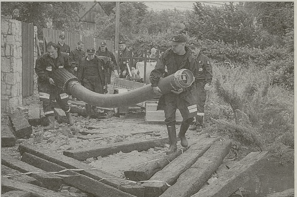
Strażacy wypompowywali wodę m.in. z domów i podwórek ul. Widłakowej
