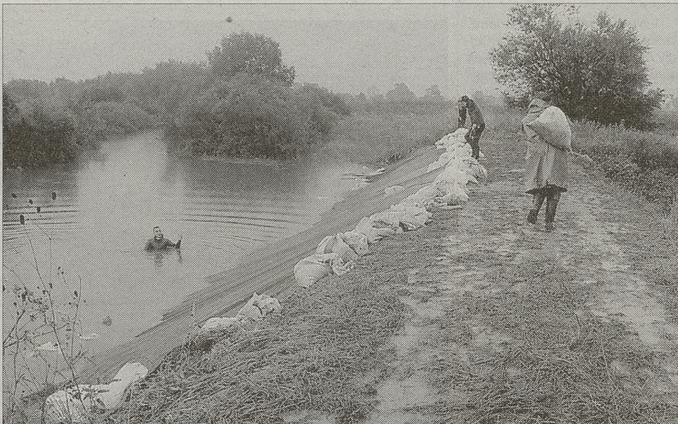
W Brzegach cały czas trwa zabezpieczanie przeciekającej śluzy na Drwini
