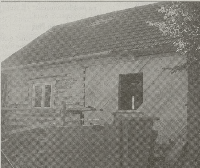
Dom państwa Tyrawów budowany jest praktycznie od nowa
