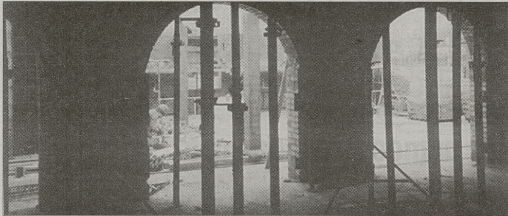
Arkadowa kolumnada we wnętrzu rekonstruowanego budynku
