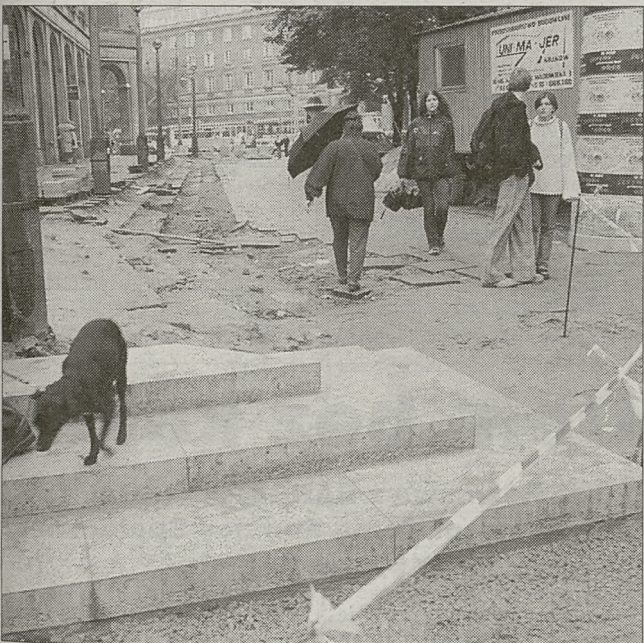
Do końca października zakończone zostaną prace przy remoncie schodów wokół placu Centralnego
