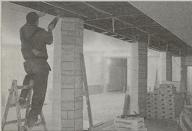
Kończą się prace adaptacyjne w przejściu podziemnym
