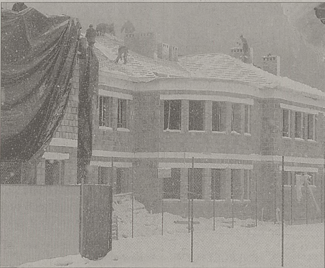
Na placu budowy gimnazjum na Zarabiu zima niestraszna ekipom budowlanym
