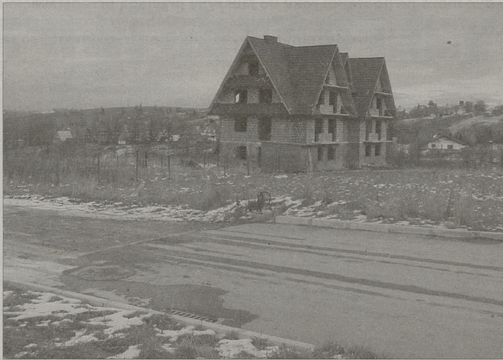
Asfaltowa droga na zakopiańskiej Pardałowce, zbudowana za pieniądze podatników, kończy się tuż przy domu jednego z koalicyjnych radnych Fot. AUTOR
