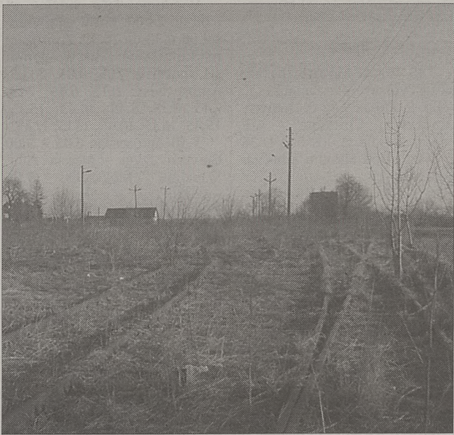
Dziś są tu jeszcze tory kolejowe. Za kilka lat powinna być dwupasmowa jezdnia.
