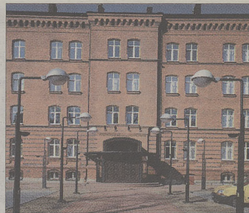
Budynek Sądu Okręgowego i Krajowego Rejestru Sądowego w Katowicach
