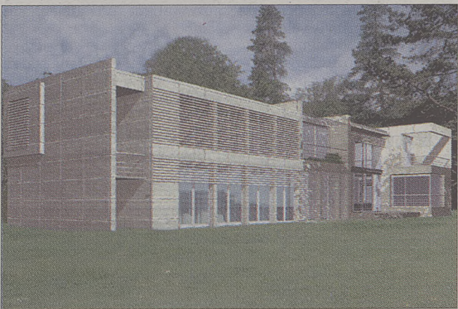
Budynek pensjonatowo-mieszkalny w Konstancinie
