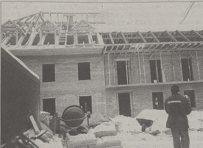
Wieżba dachowa Turówki wraz z konstrukcjami lukarn wykonana jest już w ponad 60 proc.
