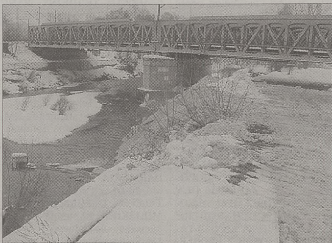
Śnieg wywożony jest nad Skawinkę w okolice wiaduktu kolejowego
