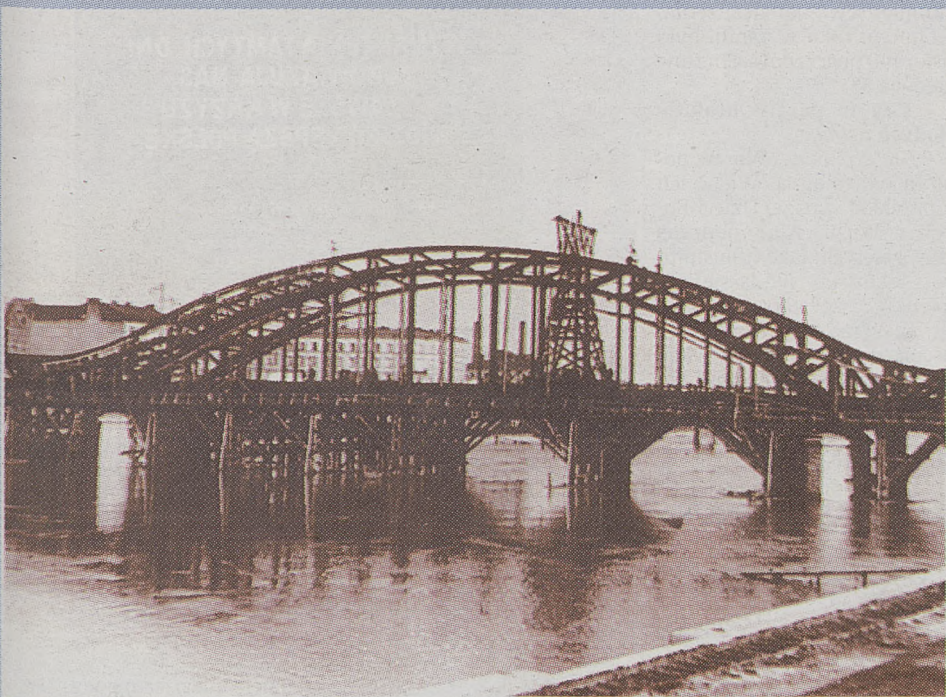
Most Piłsudskiego w ostatniej fazie budowy konstrukcji stalowej
