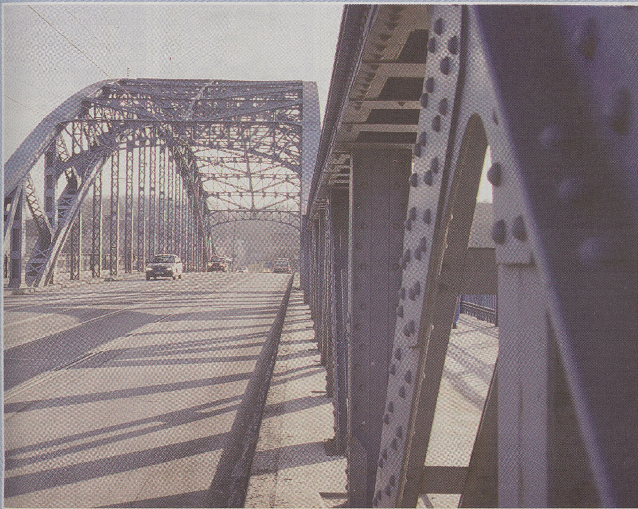
Most Józefa Piłsudskiego (IV Most); częściowo zniszczony w 1945 r., odbudowany w 1948 r. – stan obecny
