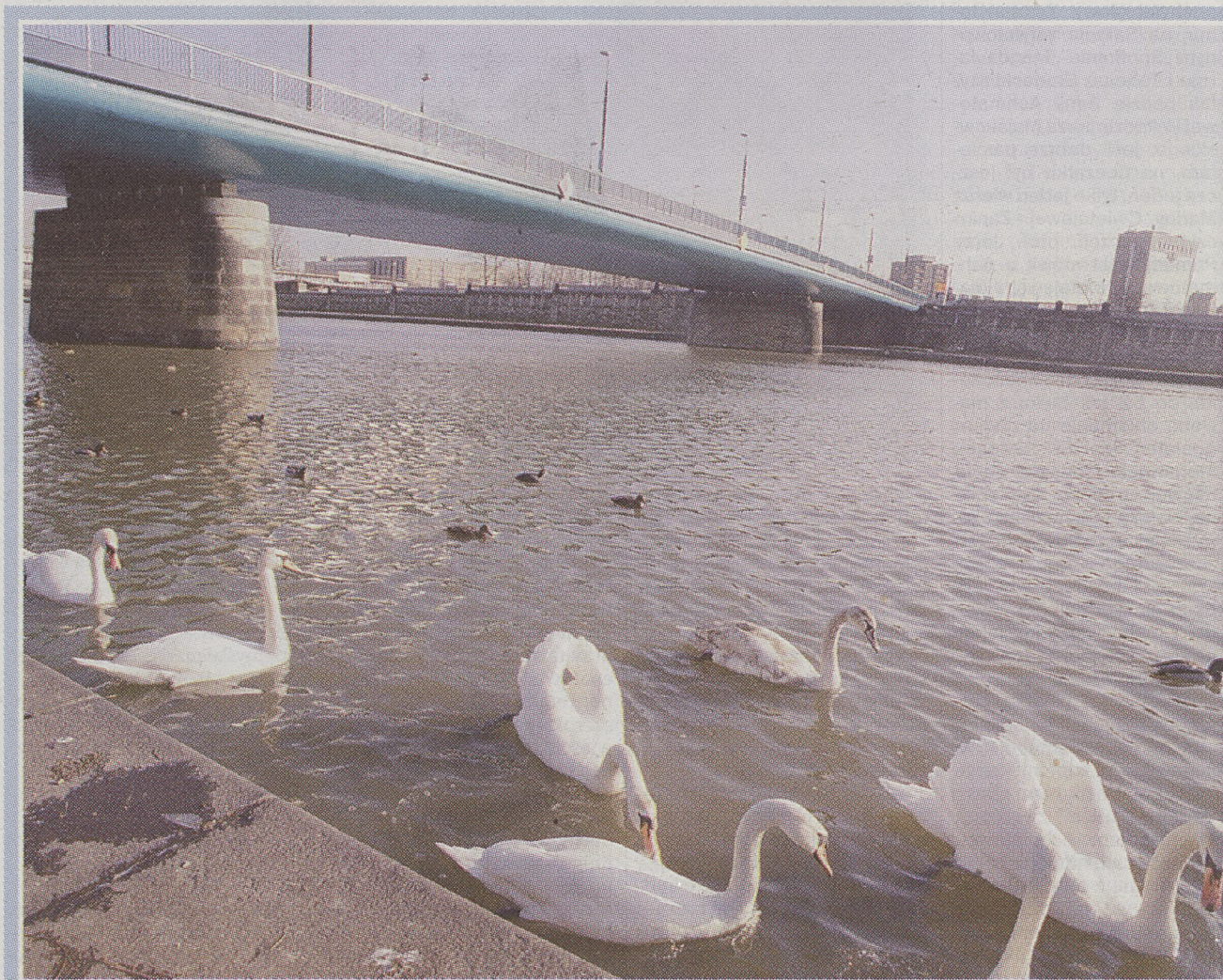
Most Powstańców Śląskich (III Most); uszkodzony w 1945 r., następnie naprawiony, w 1971 r. gruntownie zmodernizowany – stan obecny Fot. Anna Kaczmarz
