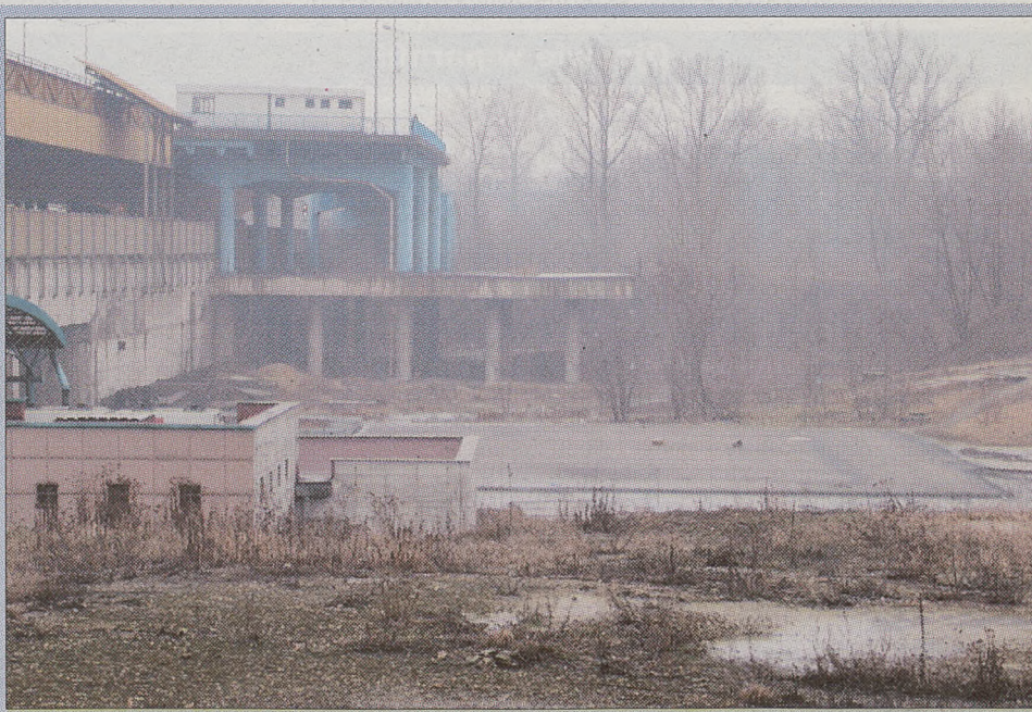
W tym miejscu powstanie nowy dworzec
