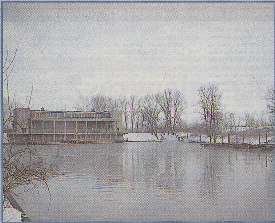
Pozostałości portu w Nowej Hucie. Na wprost stacja pomp, z prawej strony resztki przystani.
