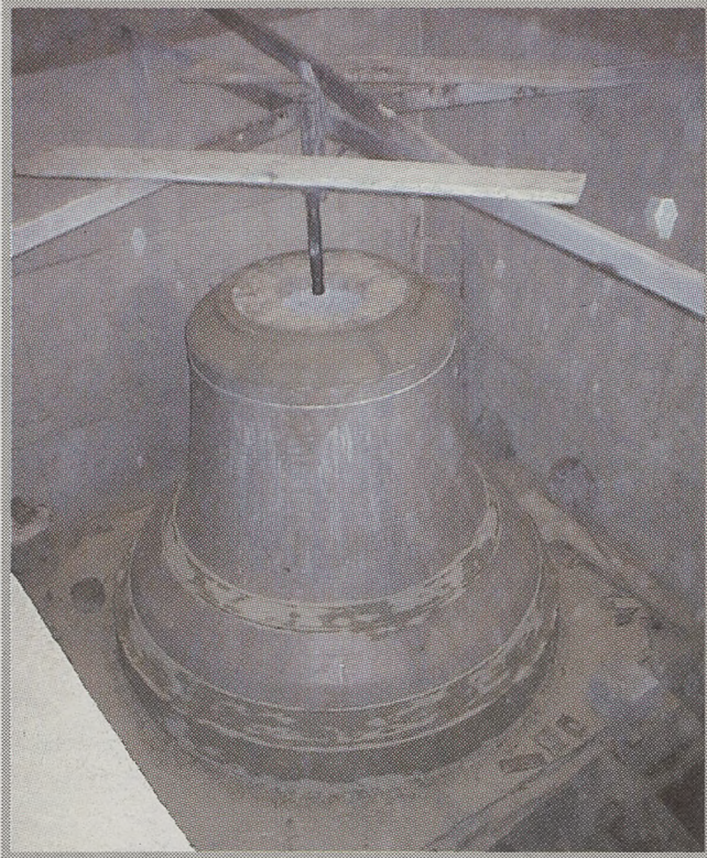
W głębokiej jamie tkwi forma dzwonu, który po odlaniu ma ważyć ok. 12 ton
