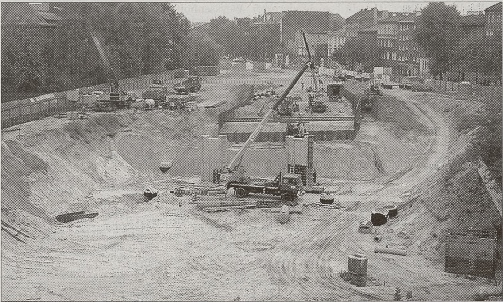
Budowa ul. Wita Stwosza jest już sporo opóźniona
