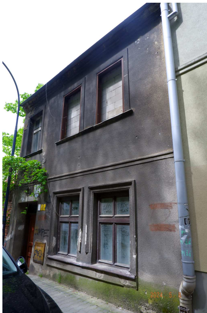
Fot. nr 192. Relikt niskiej zabudowy Podgórze pod nr 45.
