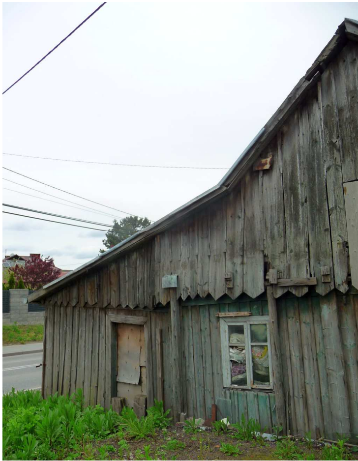
Fot. nr 391. Fragment ściany szczytowej z archaicznym okienkiem. (16.04.2024)
