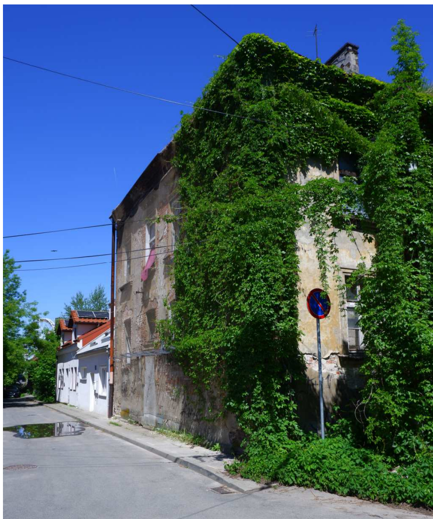
Fot. nr 70 (70-74). Ciąg dalszy zabudowy ulicy Tureckiej – fragment poniżej nr 16. (12.05.2024)
