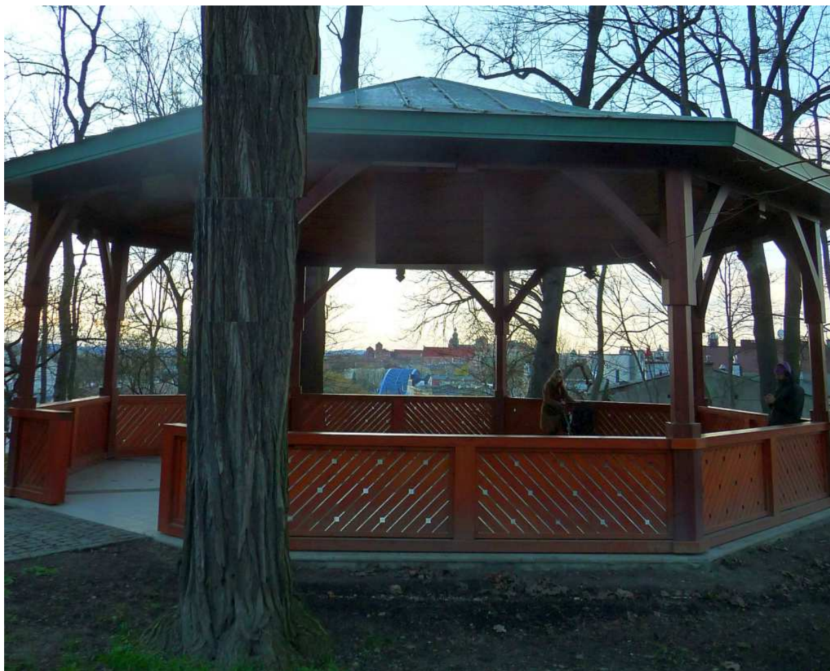
Fot. nr 149 (149-151). Cenny przykład zastosowania małej architektury parkowej w postaci drewnianej altany. (24.03.2024)
