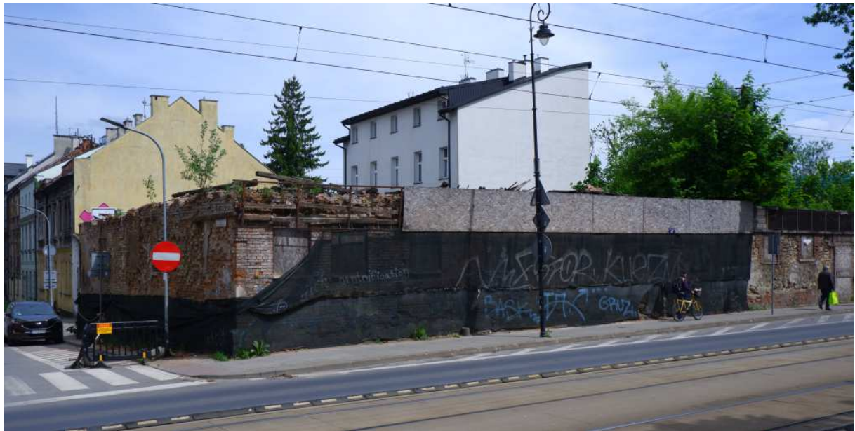
Fot. nr 199. Chyba nic już nie uratuje XVIII-wiecznego dworku pod nr 47. (08.05.2024)
