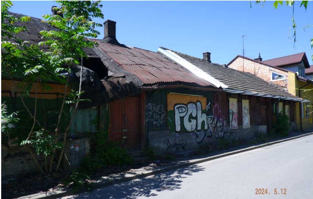
Fot. nr 65. Fragment typowo sielskiej zabudowy o nr: 19 i 21, która niebawem zniknie.
