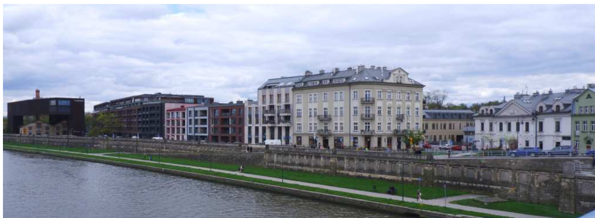
Fot. nr 207. Ulica Nadwiślańska w ujęciu od strony Grzegórzek. (04.04.2024)
