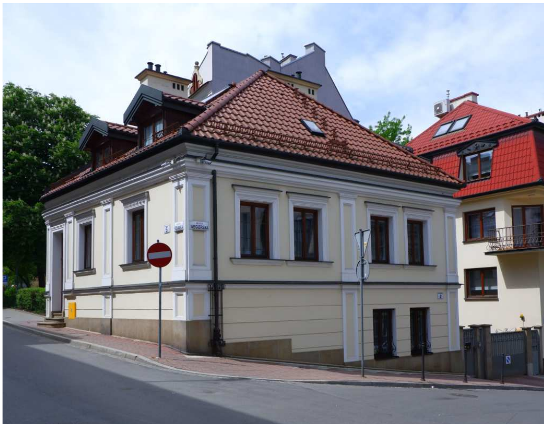
Fot. nr 181 (181-196). Wzdłuż ulicy Rękawka. Odnowiony dom pod nr 5. (08.05.2024)
