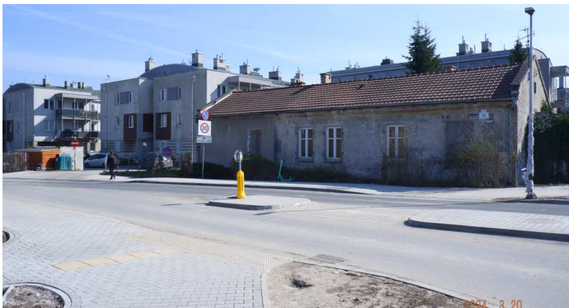
Fot. nr 37. Ostatni relikw dawnej zabudowy ulicy Pychowickiej pod nr 20.
