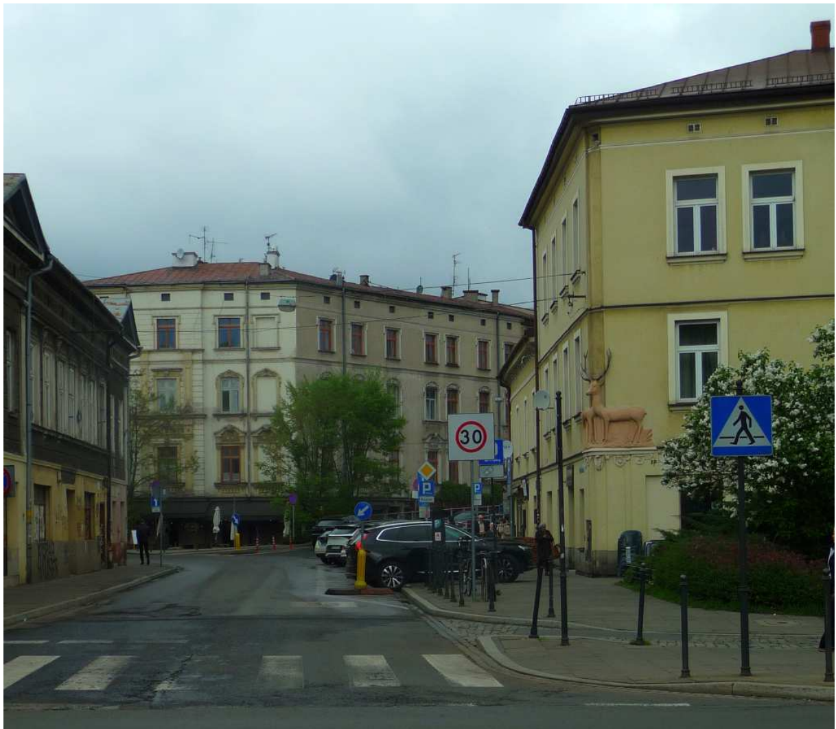
Fot. nr 210. Wzdłuż ulicy Brodzińskiego. (17.04.2024)
