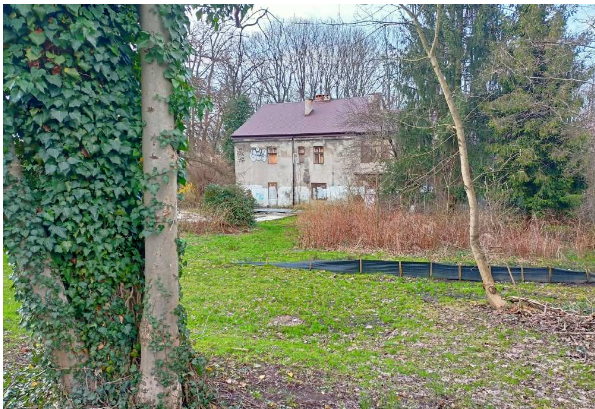
Fot. nr 252 (252-253). Stary dwór Bemów po remoncie dachu, spalonego w pożarze. (17.03.2024)
