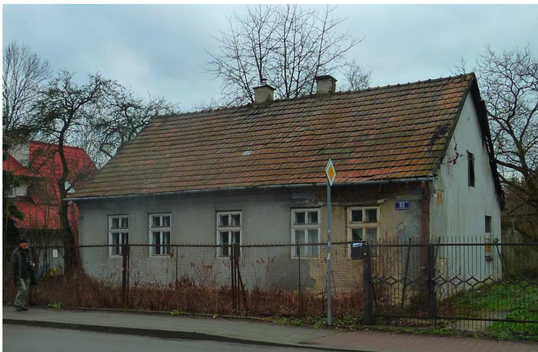
Fot. nr 35. Wielorodzinny dom pod nr 93, który jeszcze trwa. (13.03.2024)
