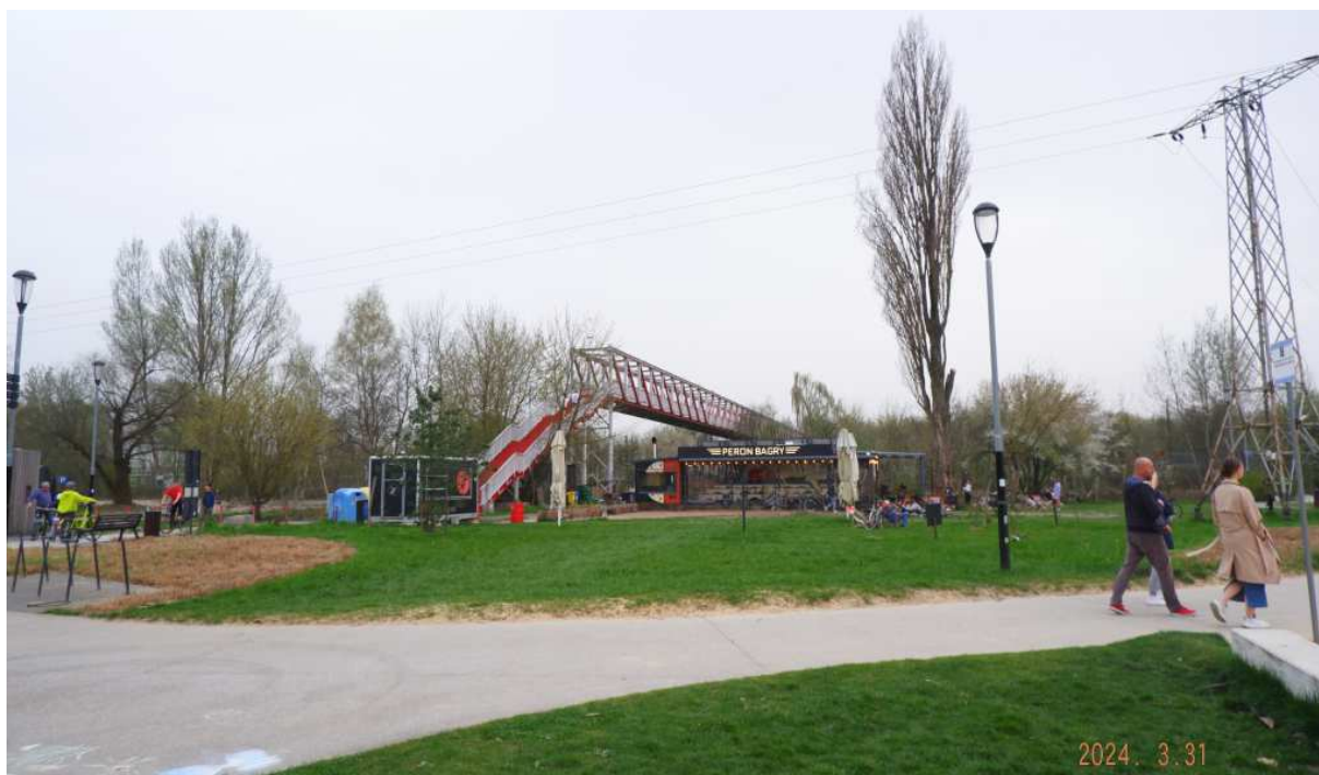
Fot. nr 295. Kładka nad torami kolejowymi.
