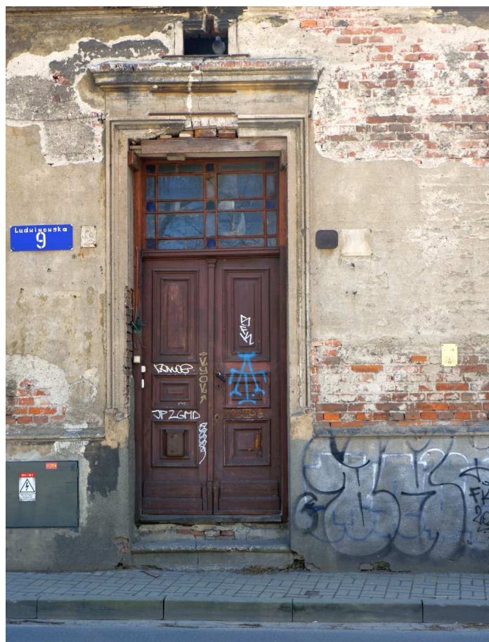
Fot. nr 76. Drzwi z mozaiką z kolorowych szybek w zwieńczeniu. (27.03.2024)
