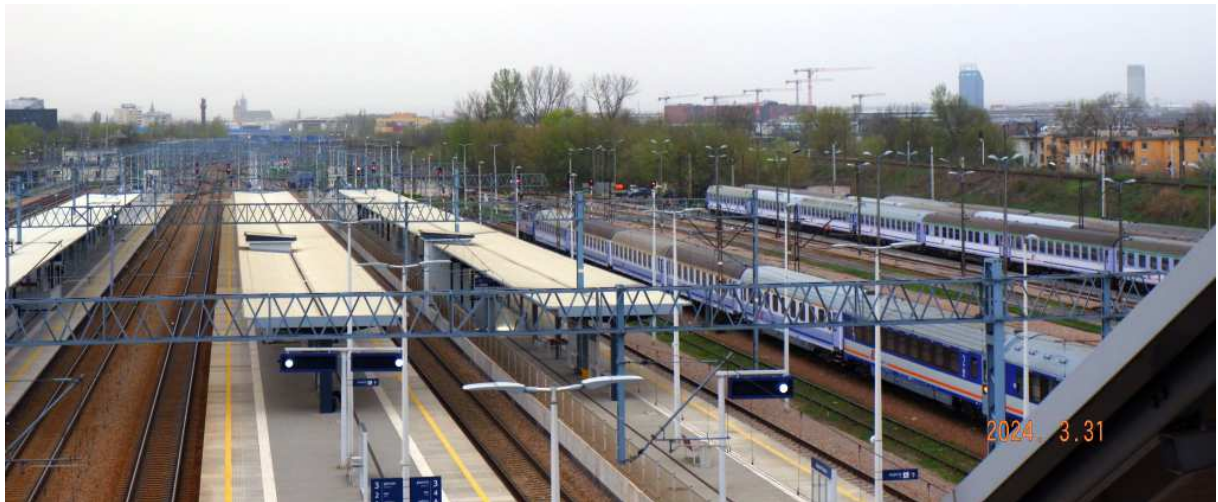
Fot. nr 257 (257-258). Widoki z wiaduktu tramwajowego nad dworcem kolejowym w Płaszowie. (31.03.2024)
