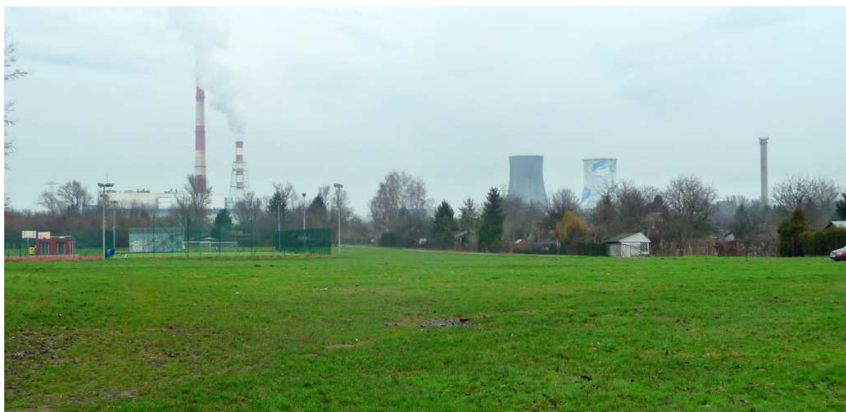
Fot. nr 256. Kominy elektrociepłowni z Łęgu w ujęciu z Małego Płaszowa. (02.03.2024)
