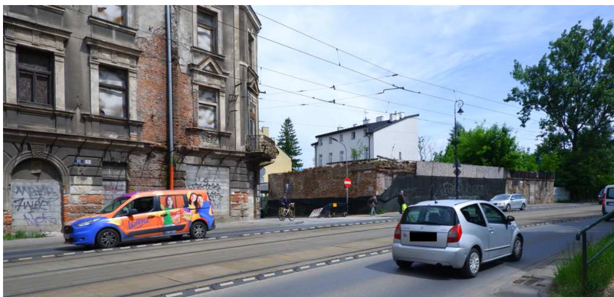
Fot. nr 198. Zabudowa ulicy o numerach: 45- 47, róg z ulicą Tarnowskiego. (08.05.2024)
