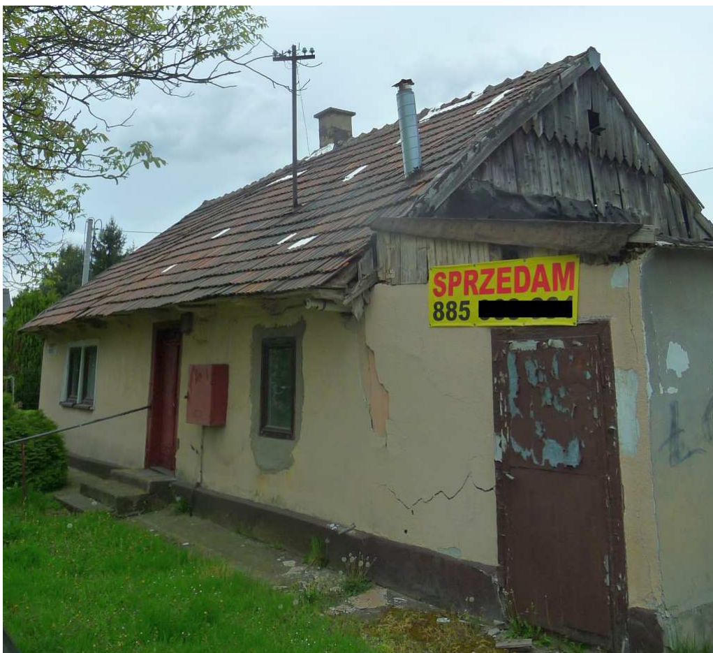
Fot. nr 395 (395-398). Niedawno przebudowana dawna chałupa z naroża ulic: Obronnej 12 i Przewiewnej. Fasada. (16.04.2024)
