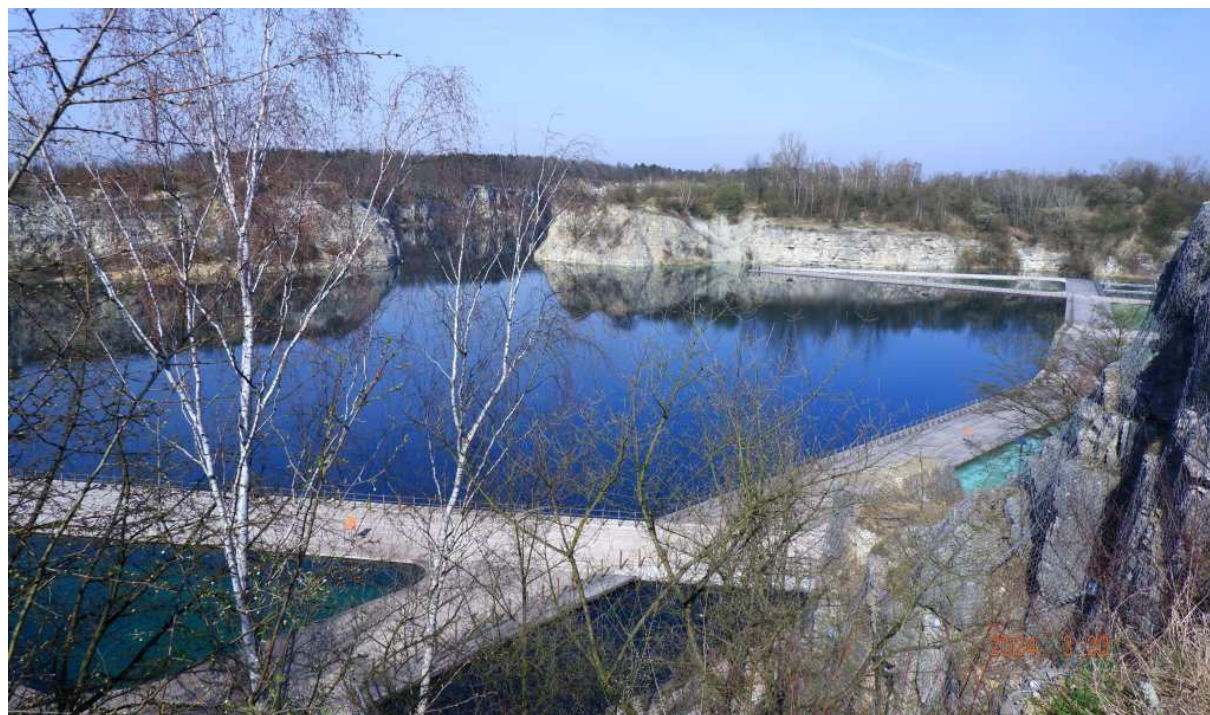
Fot. nr 42 (42-43). Widoki na zespół basenów od strony ulicy Wyłom.
