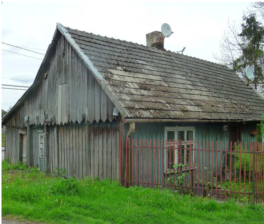
Fot. nr 392 (392-395). Widoki od strony podwórka. (16.04.2024)
