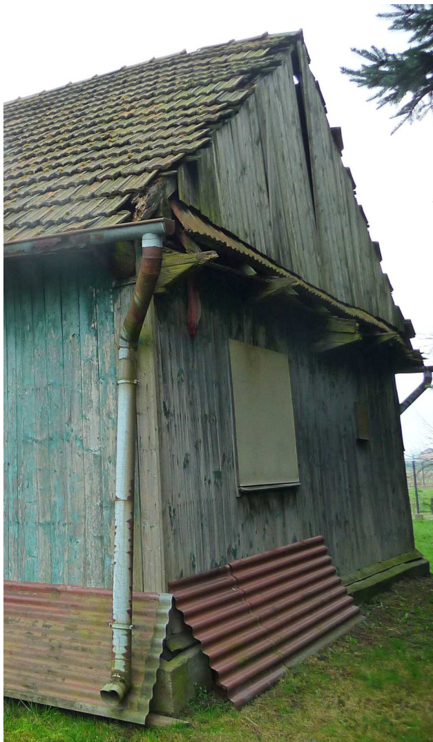
Fot. nr 438. Ściana szczytowa z okapowym dachem. (02.03.2024)
