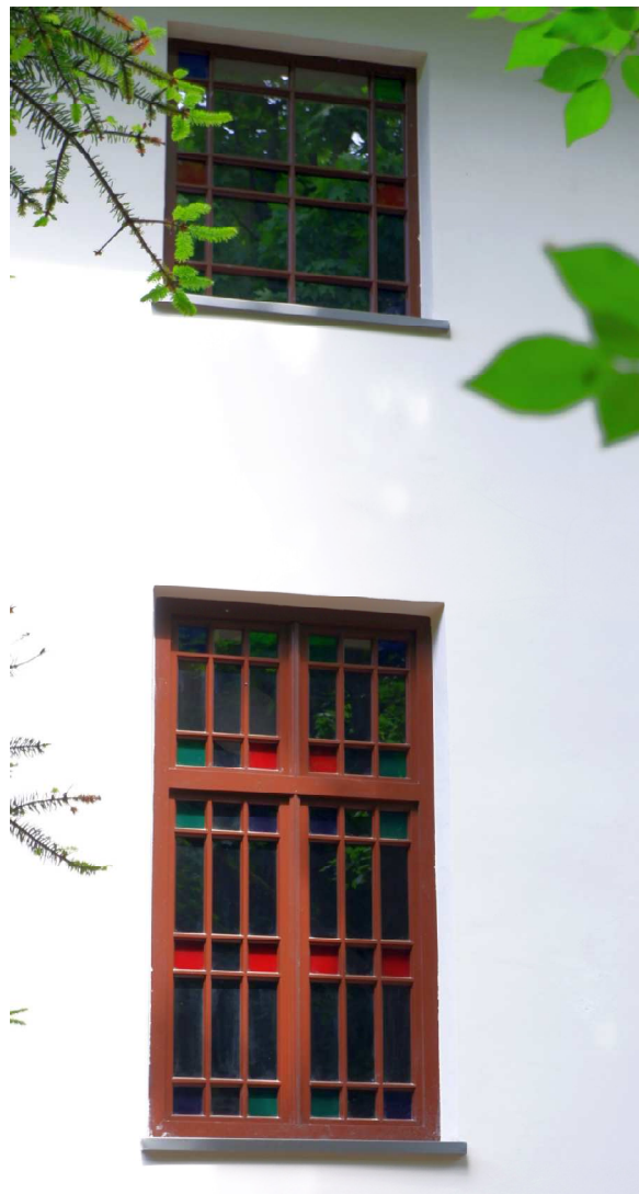
Fot. nr 196. Mozaikowe okno oficyny kamienicy z ul. Limanowskiego 54. (08.05.2024)
