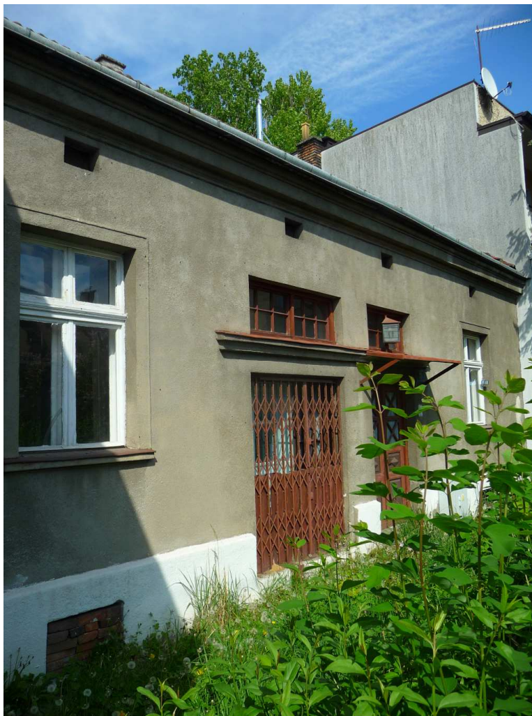
Fot. nr 19. Parterowy dom o numerze 11. (25.04.2024)
