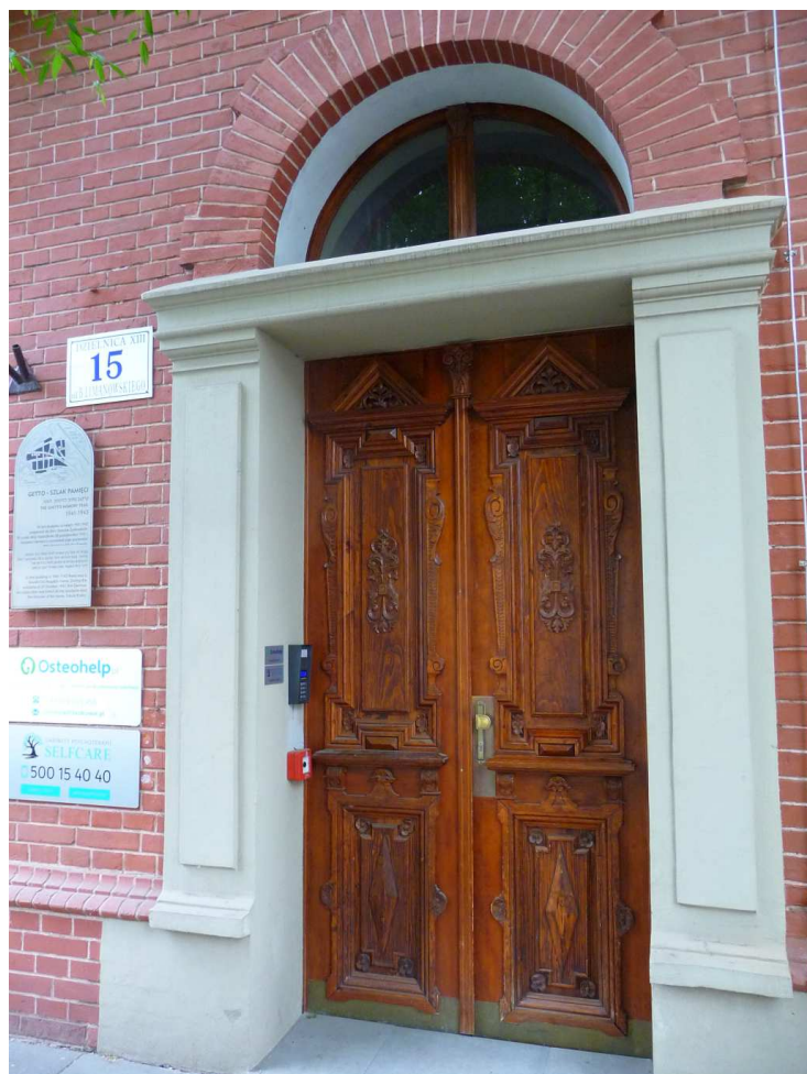
Fot. nr 226. Drzwi kamieniczki spod nr 15. (17.04.2024)
