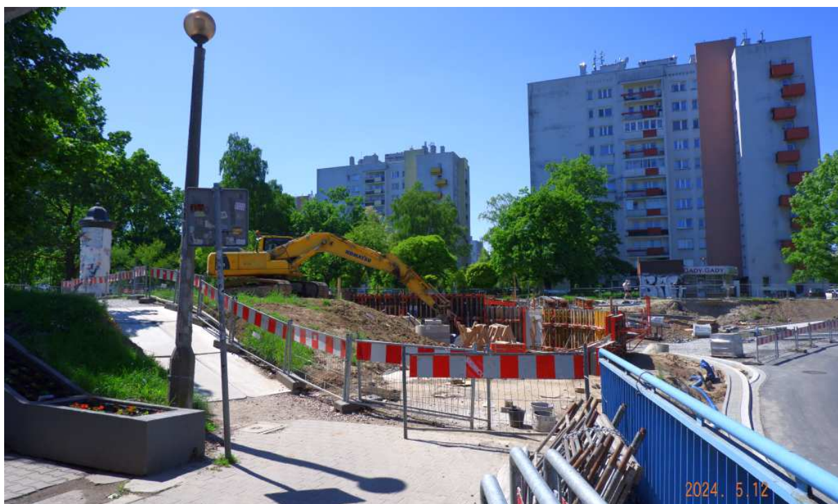
Fot. nr 82 (82-86). Przygotowania do budowy nowych apartamentowców na przedpolu osiedla Podwawelskiego. Trwają prace przy modernizacji ślepego fragmentu ulicy Barskiej.
