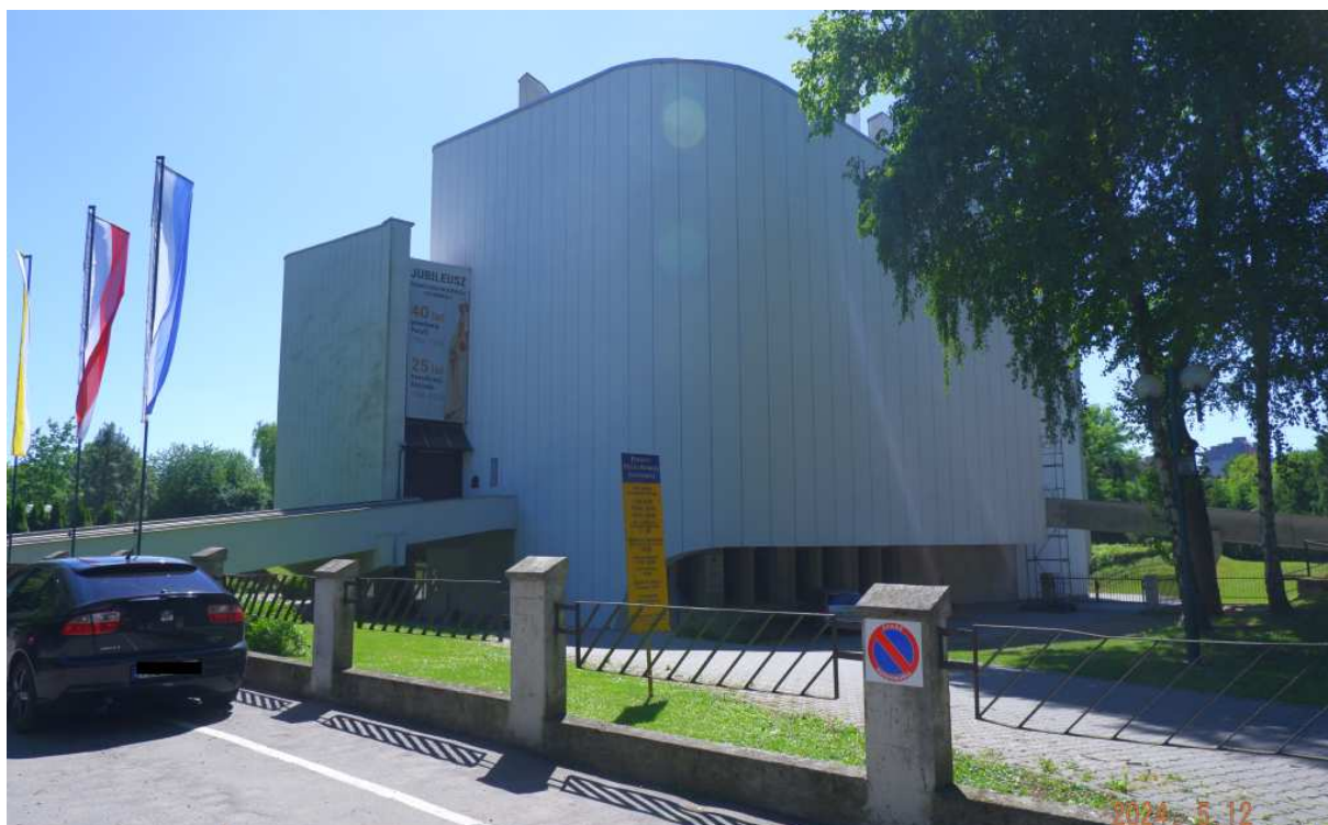
Fot. nr 104. Kościół p.w. Matki Boskiej Fatimskiej wybudowany przy ulicy Komandosów 18, wybudowany w miejscu ziemnego fortu piechoty St 3 z czasów Twierdzy Kraków, po którym pozostały fragmenty wału ziemnego.
