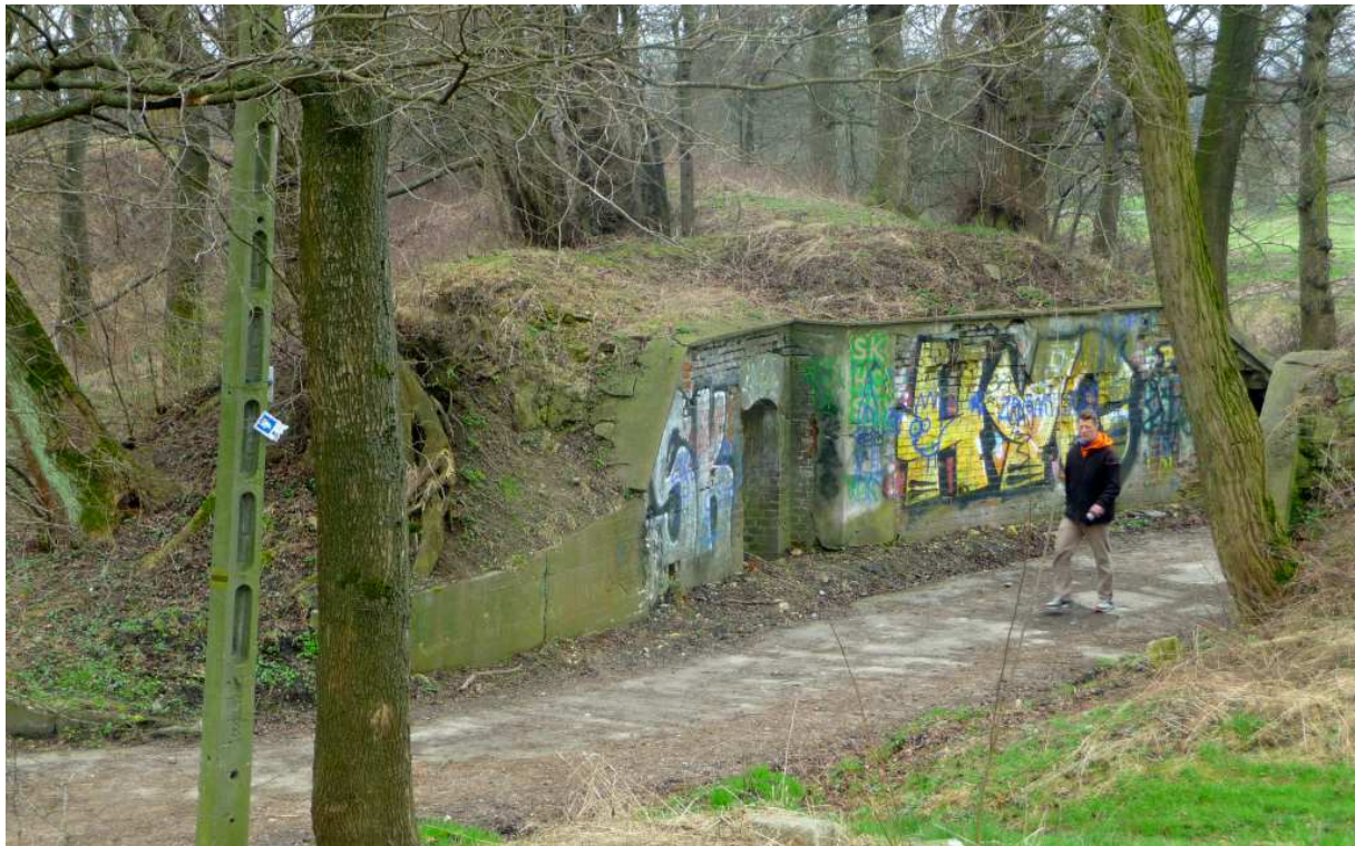
Fot. nr 429. Wartownia przy wjeździe. (02.03.2024)
