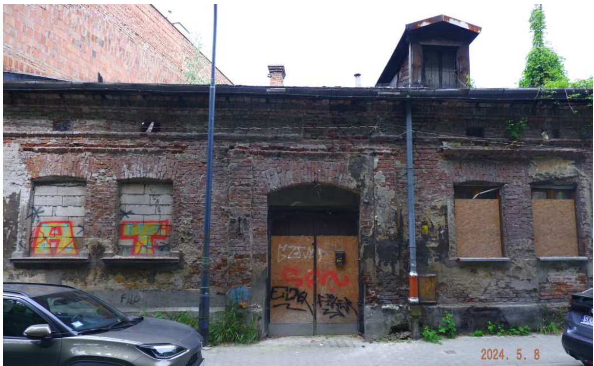
Fot. nr 194. Parterowy relikt pod nr 53. (08.05.2024)
