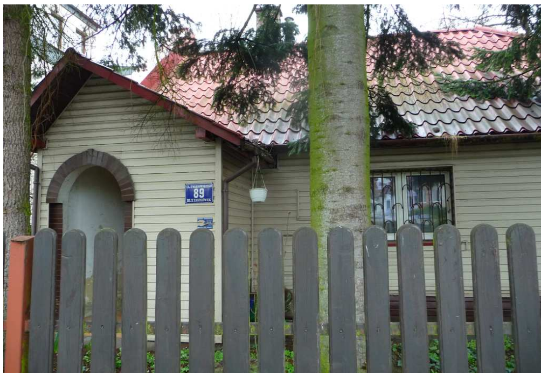
Fot. nr 34. Współcześnie pokryty sidingiem podmiejski domek pod nr 89. (13.03.2024)
