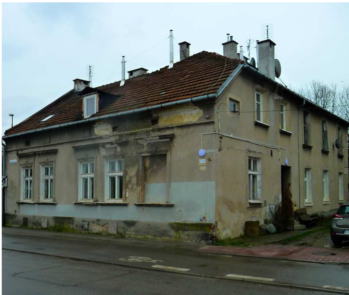
Fot. nr 32. Rozległy dom pod nr 80. (13.03.2024)
