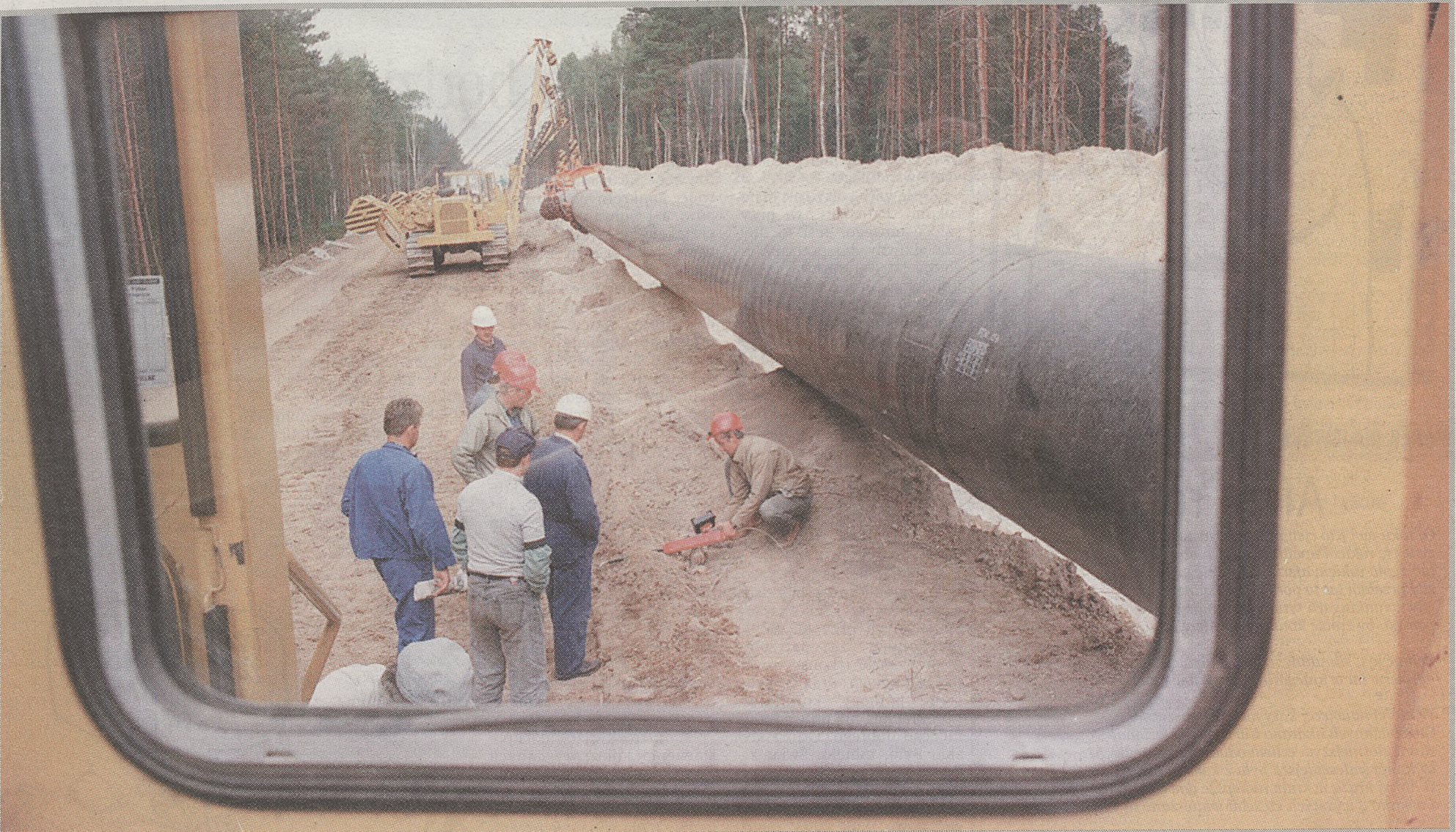
Międzyrzecz – budowa gazociągu Wschód–Zachód
