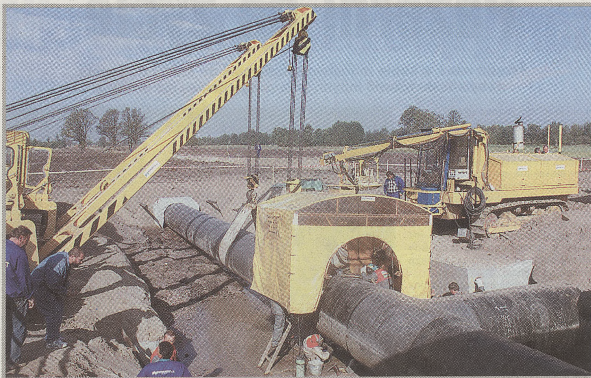
Zakończenie budowy pierwszej nitki gazociągu jamalskiego
