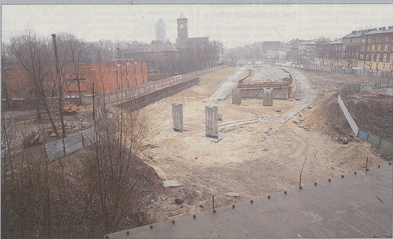
Obecnie w tym miejscu wykonano już m.in. najazd na estakadę z przyczółkiem i dwie pary filarów pod estakadę Fot. Piotr Kędzierski
