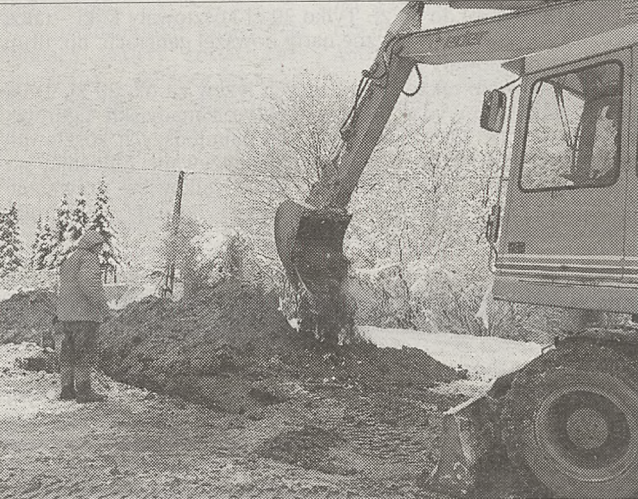
Na ul. Millana trwa budowa kanalizacji sanitarnej Fot. Anna Kaczmarz
