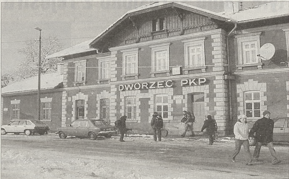
Kapitałny remont budynku dworca powinien, zdaniem skawinian, przyczynić się do poprawy bezpieczeństwa w rejonie stacji kolejowej
