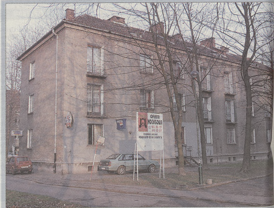
Budynek przy osiedlu Na Skarpie 18, w którym mieszczą się: biuro spółki „Luna”, zakład fryzjerski, bar oraz pokoje gościnne Fot. Anna Kaczmarska
