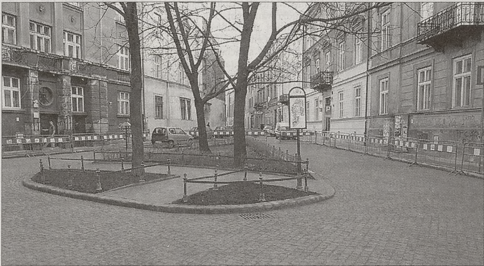
Po 5 latach zakończono remont ul. św. Marka
