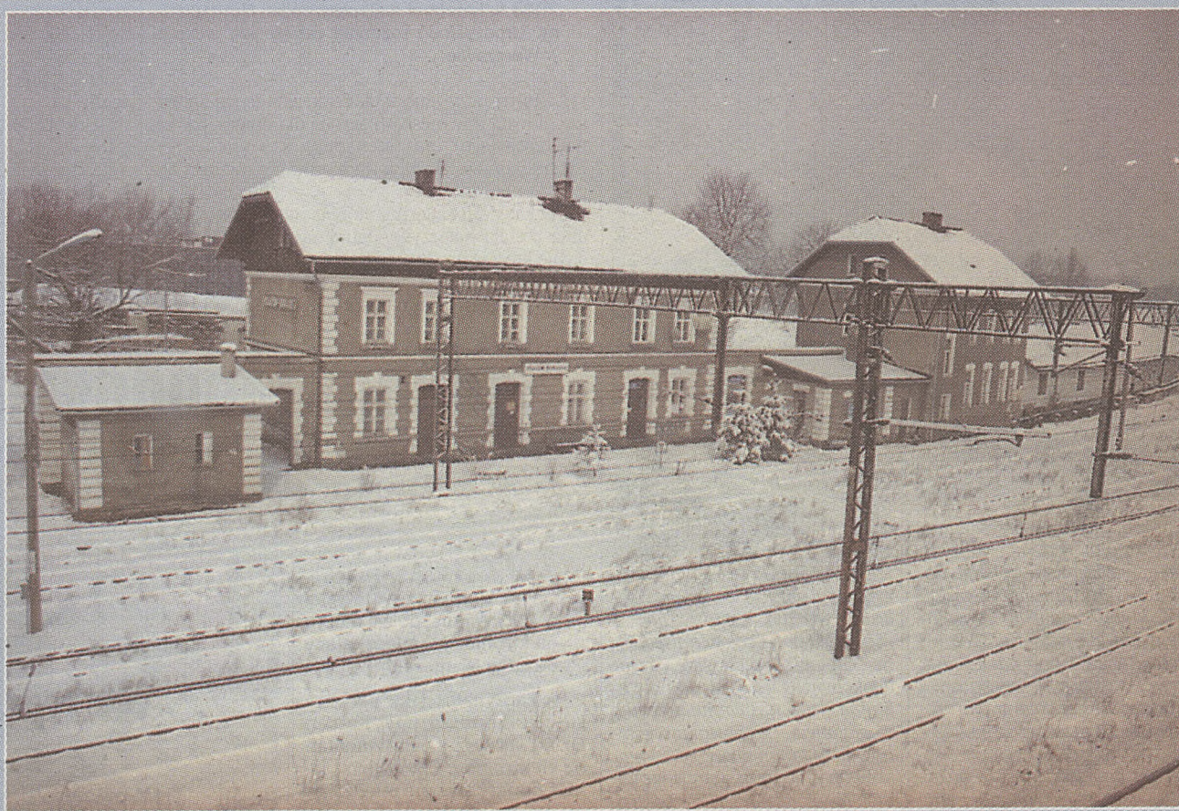
Na stacji Kraków-Bonarka nic dziś nie zdradza, że kiedyś był tu najprawdziwszy węzeł kolejowy
