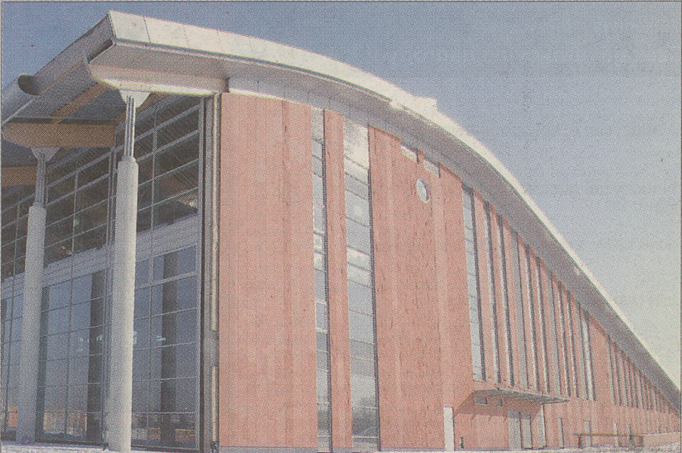
Przy budowie biblioteki Papieskiej Akademii Teologicznej w Pychowicach wykorzystywane są technologie na miarę XXI wieku
