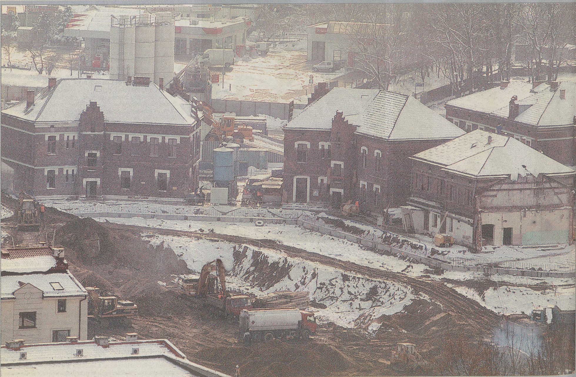
Centrum handlowe Galeria Kazimierz. Wielka inwestycja ma powstać w ciągu nieco ponad roku, na wyjątkowo trudnym terenie (niedawno płynęła tu Wisła). Dzięki nowoczesnym technologiom da się wykonać potężne fundamenty na grząskim gruncie.
