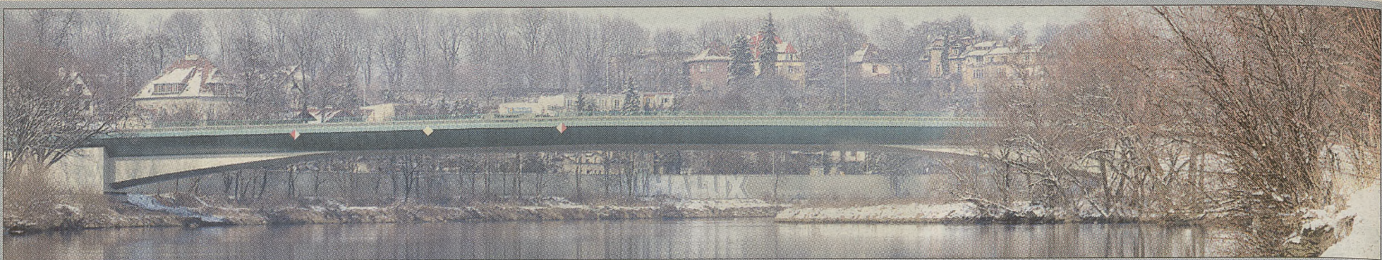
Most Zwierzyniecki o rozpiętości przęsła 132 m został postawiony w rekordowym tempie – prace budowlane trwały niespełna 12 miesięcy. Do budowy wybrano beton sprężony.
