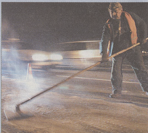
Nowa nawierzchnia była posypywana piaskiem i wyrównywana
