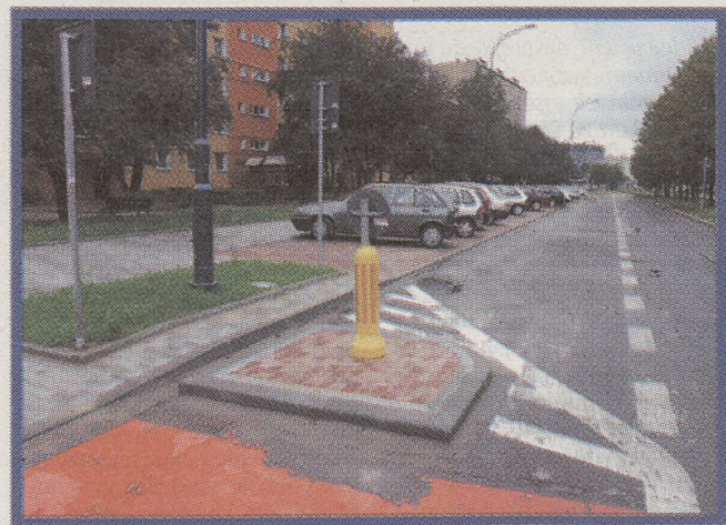
Dzielnica kontynuować będzie budowę miejsc parkingowych przy ul. M. Dąbrowskiej Fot. Anna Kaczmarz
