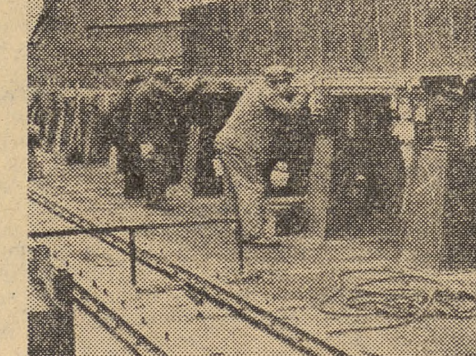
Pracownicy stoczni gdańskiej kładą pierwszy segment stępki. Niedługo w stoczni tej powstanie nowy drobnicowiec do przewożenia drewna. Wielu pracowników stoczni to wychowankowie Conradinum
