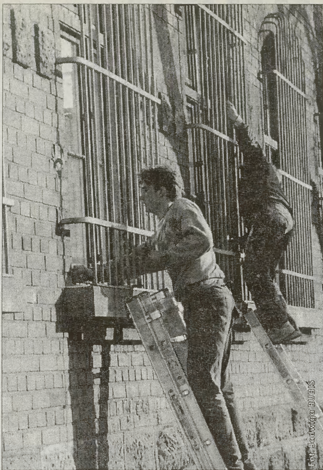
W gmachu przy al. Mickiewicza czyszczenie okien i malowanie futryn. Widocznie wyczuli już tu wiosnę
