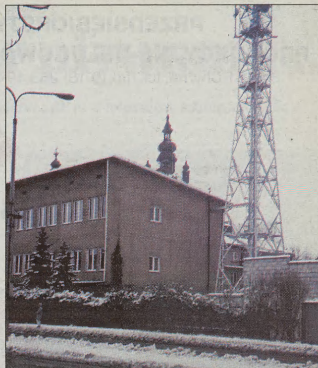
Budynek RT w Nowym Targu z wieżą radiolini
