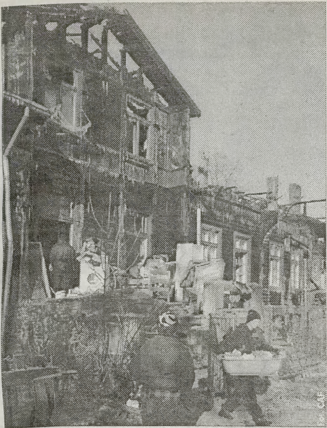
Siedemnaście rodzin zostało pozbawionych dachu nad głową w wyniku pożaru, który wybuchł w sobotę wieczorem w drewnianym budynku przy al. Włókniarzy w centrum Łodzi. Prawdopodobną przyczyną katastrofy było podpalenie. W akcji gaśniczej udział wzięło m.in. 20 jednostek straży pożarnej. Nikt z mieszkańców doszczętnie spalonego, zabytkowego budynku nie odniósł obrażeń. Pogorzelcy zostali zakwaterowani w hotelach; nie udało się uratować ich dobytku.
