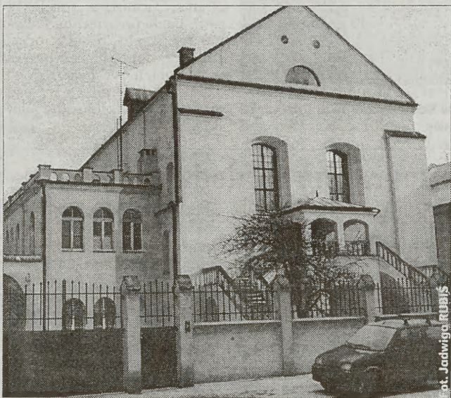
Odnowiony budynek bóżnicy Izaaka. Schodki prowadzą na galerię dla kobiet
