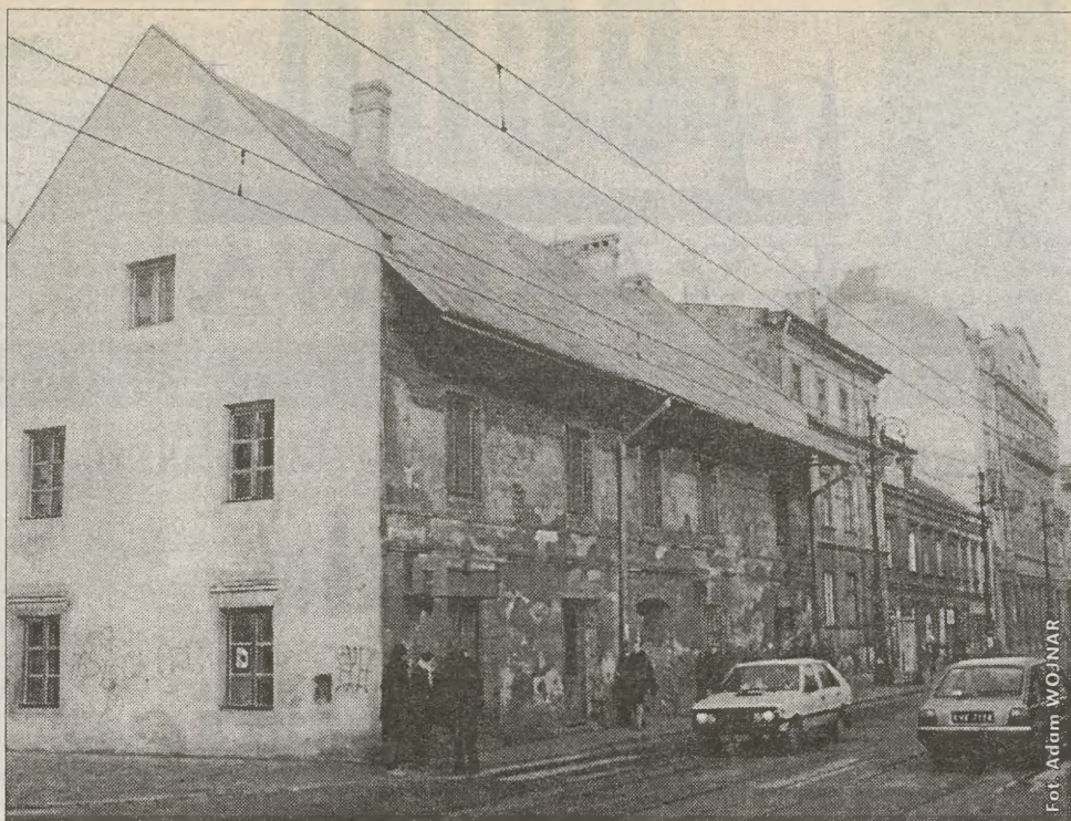
Kiedys była tu restauracja i zakłady usługowe. Dziś posesja przy ul. Piłsudskiego straszy odrapaną elewacją i pustymi oknami
