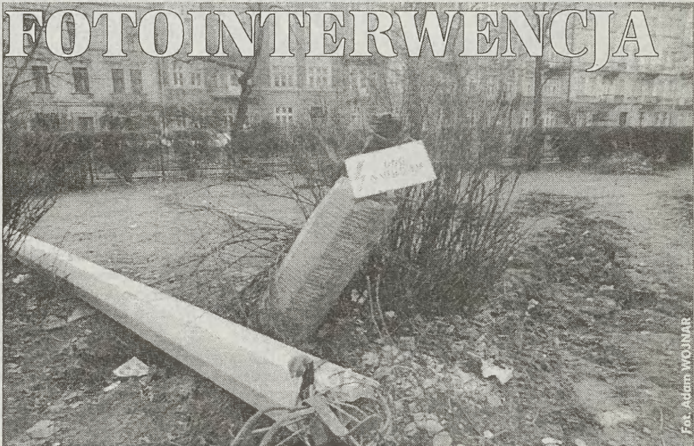
Kraków, ul. Dietla. Słup oświetleniowy, złamany prawdopodobnie w czasie wypadku samochodowego, straszy „pod napięciem”
