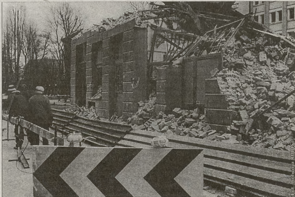
W sobotę przez dwie godziny zablokowany został ruch na ul. Czarnowiejskiej. Trwała rozbiórka starego budynku AGH. Okazało się, że konstrukcja jest tak nadwątlona, iż bez pomocy Straży Pożarnej, wykonanie prac nie byłoby możliwe. (JR)
