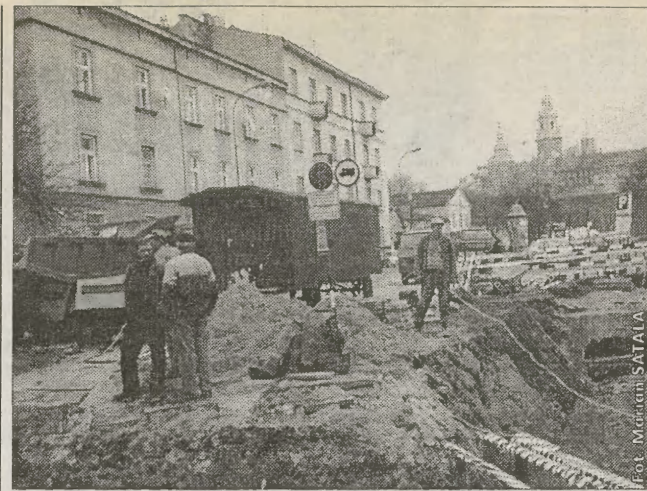
Remont ulicy Zwirzyńskiej i rozkopana ulica Powiśle, gdzie wymienia się instalację gazową, spowodowały, że ważny węzeł komunikacyjny pod „Jubilatem” jest całkowicie zablokowany. Tworzą się gigantyczne korki jadących od Wawelu w kierunku Bagateli. Pojazdy, skręcające w ul. Piłsudskiego, blokują przejazd tramwajom (mas)
