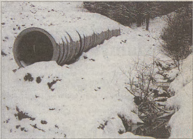
Poszło o te betonowe kręgi nad potokiem
