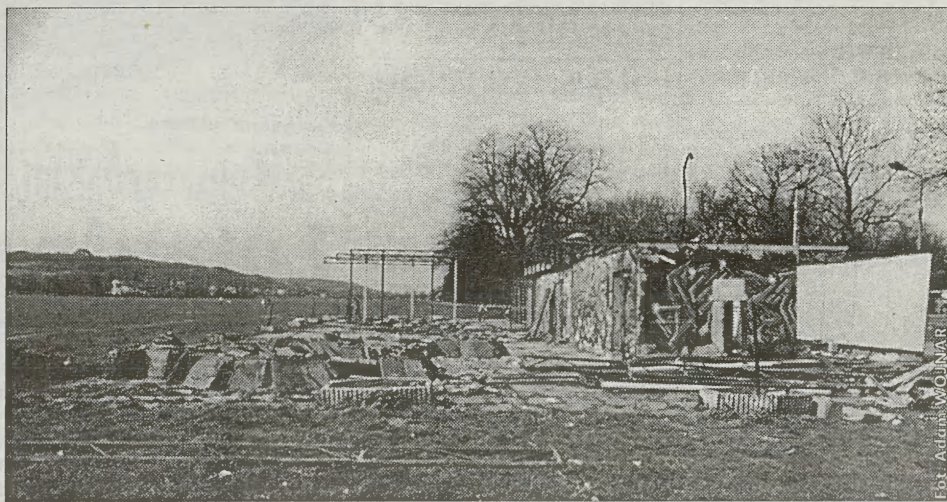
Wreszcie ktoś wziął się za szpecący Błonia pawilon. Gospodarzem położonego opodal parku Jordana budynku był „Jubilat”. Z dnia na dzień podczas rozbiórki znikają kolejne elementy straszdyka. Jak się dowiedzieliśmy nie zastąpi go nic podobnego. Będzie tu czysta zielona murawa...
