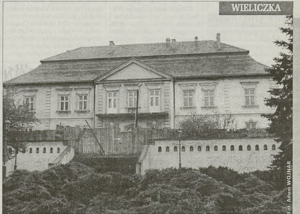
Pałac Konopków w Wieliczce miał być, po remoncie, siedzibą władz powiatowych. Tymczasem ani końca remontu nie widać, ani nie ma szans na to, by Wieliczka była siedzibą powiatu...
