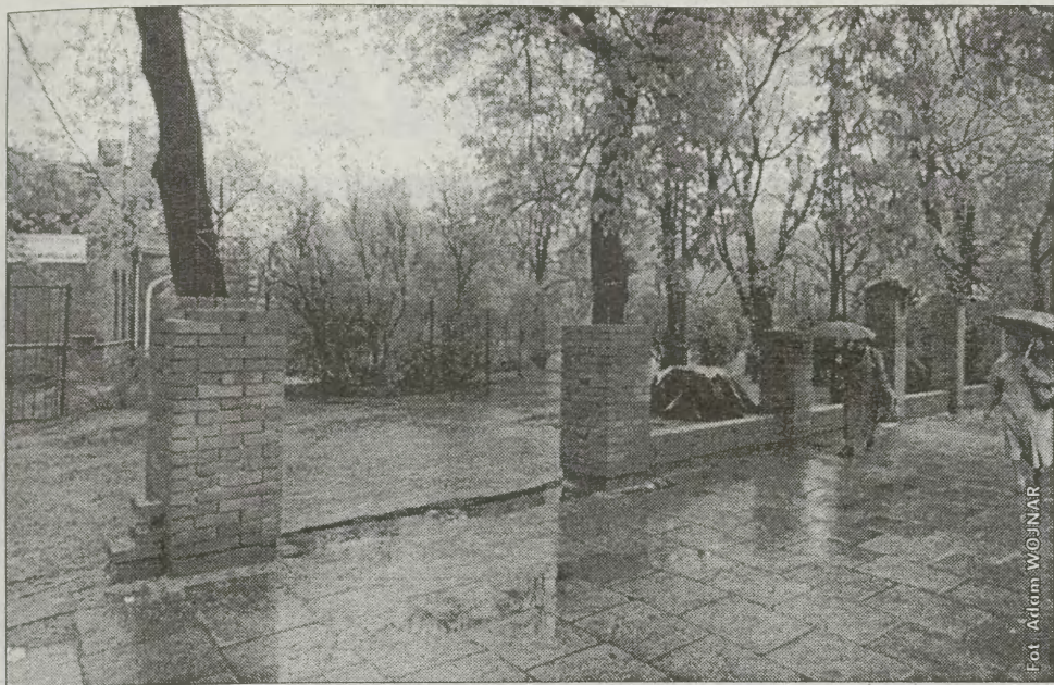
Trwają prace przy ogrodzeniu parku Strzeleckiego od strony ul. Lubicz. Czy wpłynie to na bezpieczeństwo w tej okolicy?
