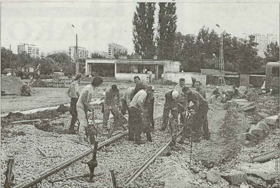
Remont pętli tramwajowej w Prokocimiu
