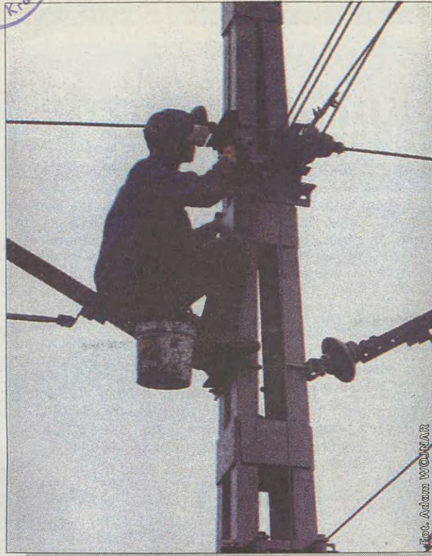
Wraz z remontem torowiska tramwajowego w Prokocimiu naprawiane są słupy trakcyjne
