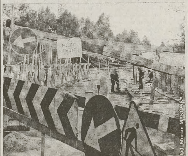
Remont ul. Podmokłej
