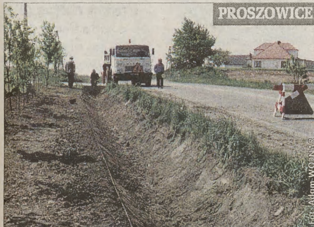
W gminie Koniusza i Proszowice trwają prace związane z zabezpieczeniem jezdni. Pracownicy zakładają rowy odwadniające i montują chodniki. Poprawi się dzięki temu bezpieczeństwo na drodze, a i okoliczni mieszkańcy nie będą się już skarżyć, że w czasie ulewnych deszczy, woda z jezdni zalewa ich piwnice. (AS)
